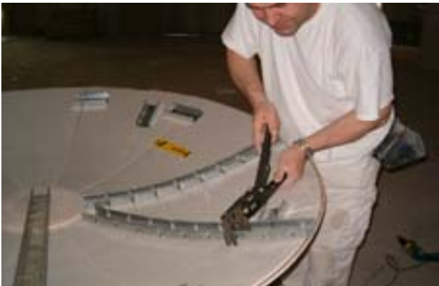
Biegen der CD-flex Profile mit Universalzange
