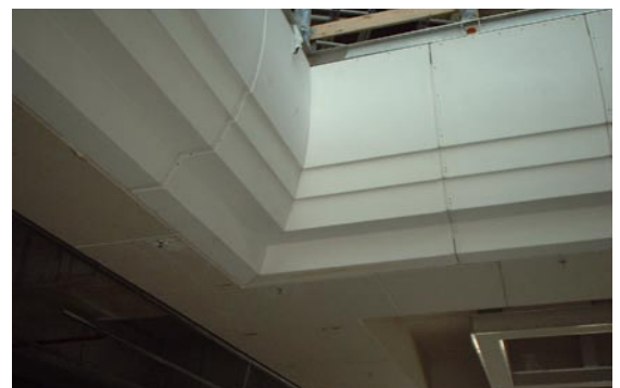
Sichtseitige Verschraubung der Elemente
