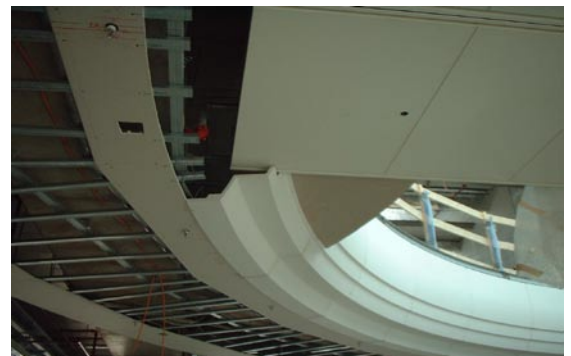
Anschluss an Unterdecke mit Schattenfuge
