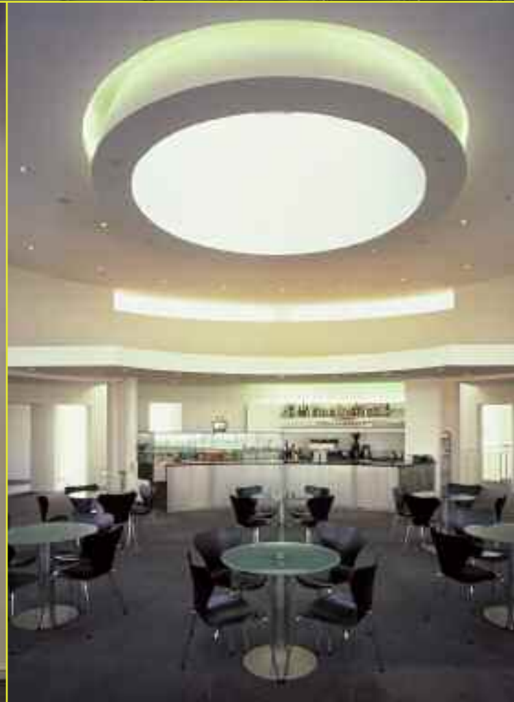
Matthias Lange, Lafarge Gips GmbH: „Der Lichtkegel in der Decke war eine besonders schwierige Aufgabe. Mit Hilfe einer flexiblen Unterkonstruktion und LaCurve konnte diese hervorragend gelöst werden.“
