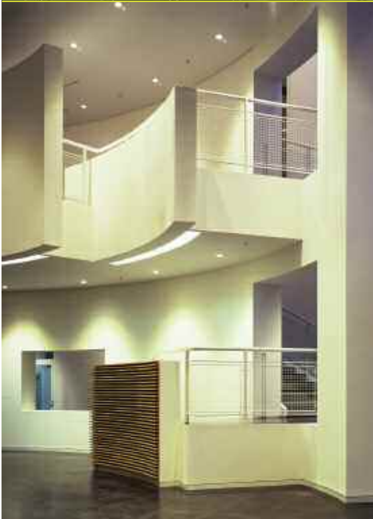
Matthias Lange, Lafarge Gips GmbH: „Der Lichtkegel in der Decke war eine besonders schwierige Aufgabe. Mit Hilfe einer flexiblen Unterkonstruktion und LaCurve konnte diese hervorragend gelöst werden.“
