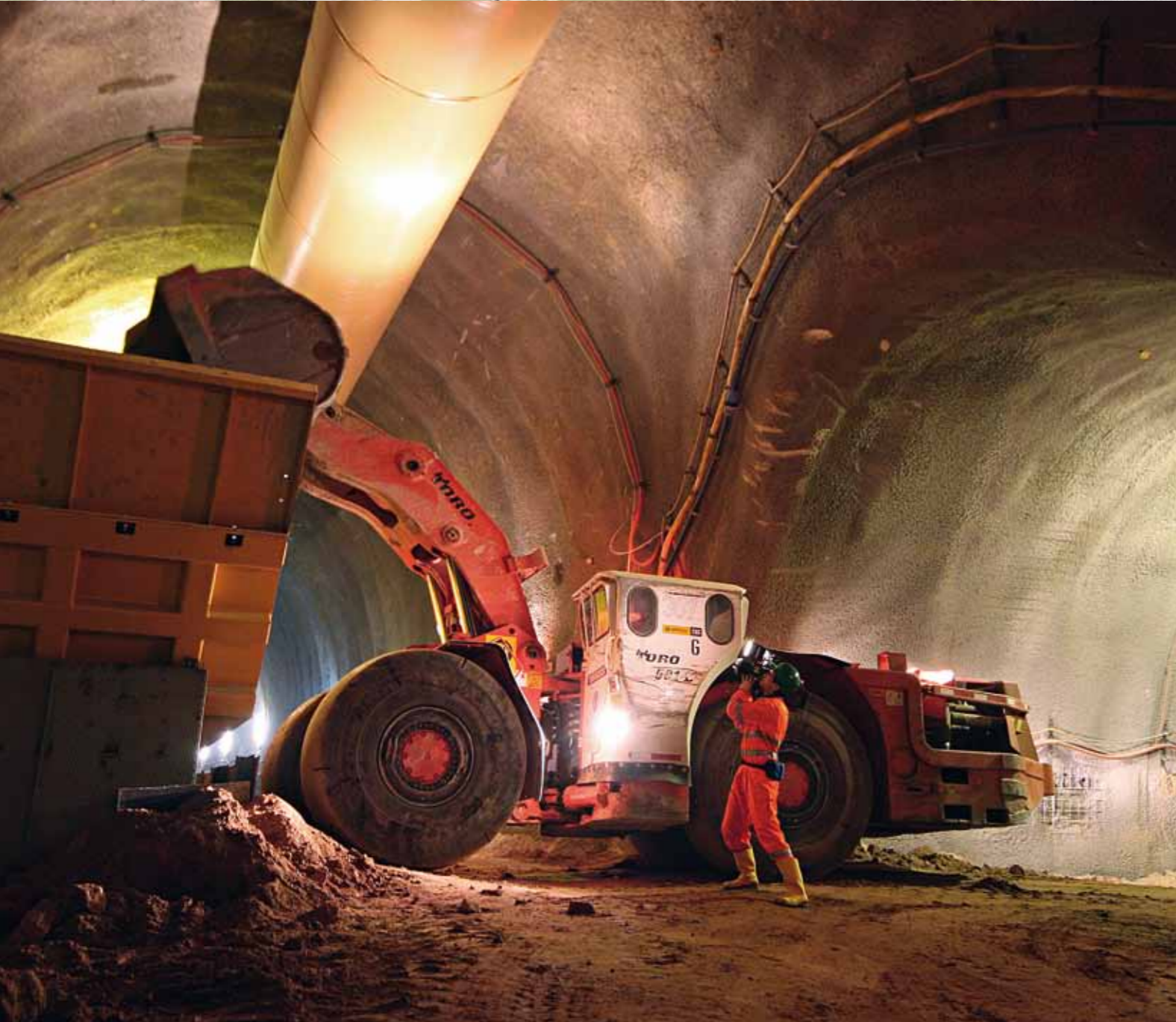
Der Bibratunnel wird im Sprengvortrieb mit anschließender Spritzbetonsicherung hergestellt
