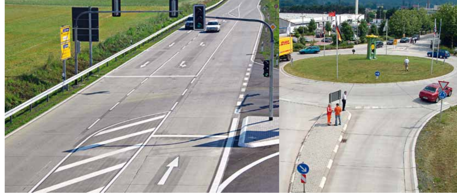
Foto 1: Umgehungsstraße B 3 bei Friedberg (Hessen)
