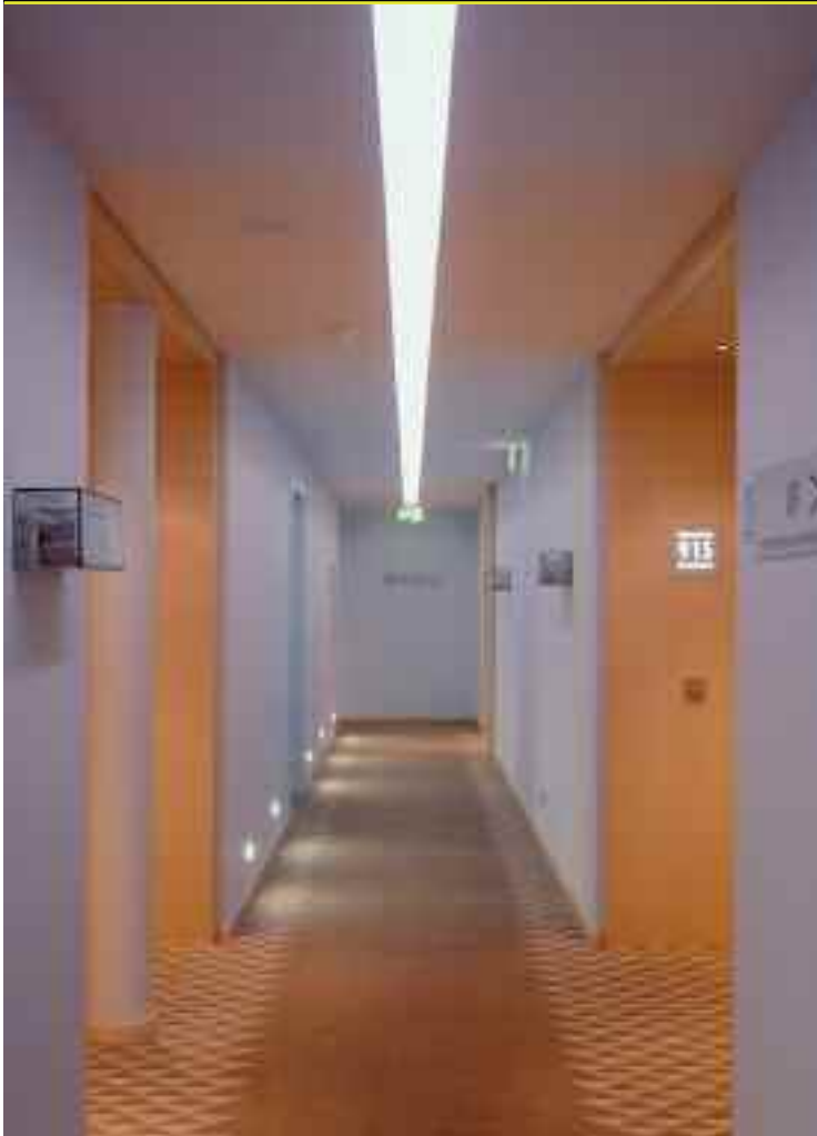
Bernd Gülle, Heinz Mänz GmbH: „Eine große Arbeitserleichterung waren die exakten, scharfen Oberkanten der Formteile. Dadurch konnten wir ganz auf Eckschutzschienen verzichten. Diese sauber anzuspachteln, wäre bei der Menge und dem Licht praktisch unmöglich.“
